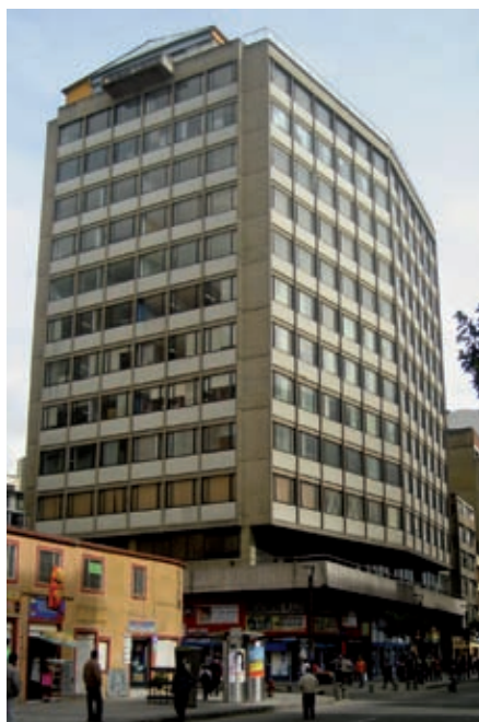
> Edificio para la Acción Cultural Popular. También conocido como Edificio Cardenal Luque, Edificio Calle 20, Ministerio de Obras Públicas y Transporte o Contraloría General de la República. Foto: Carlos Niño Murcia
