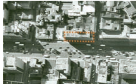
>1967. Aparece ya construido el edificio para la Colombiana de Capitalización. IGAC
