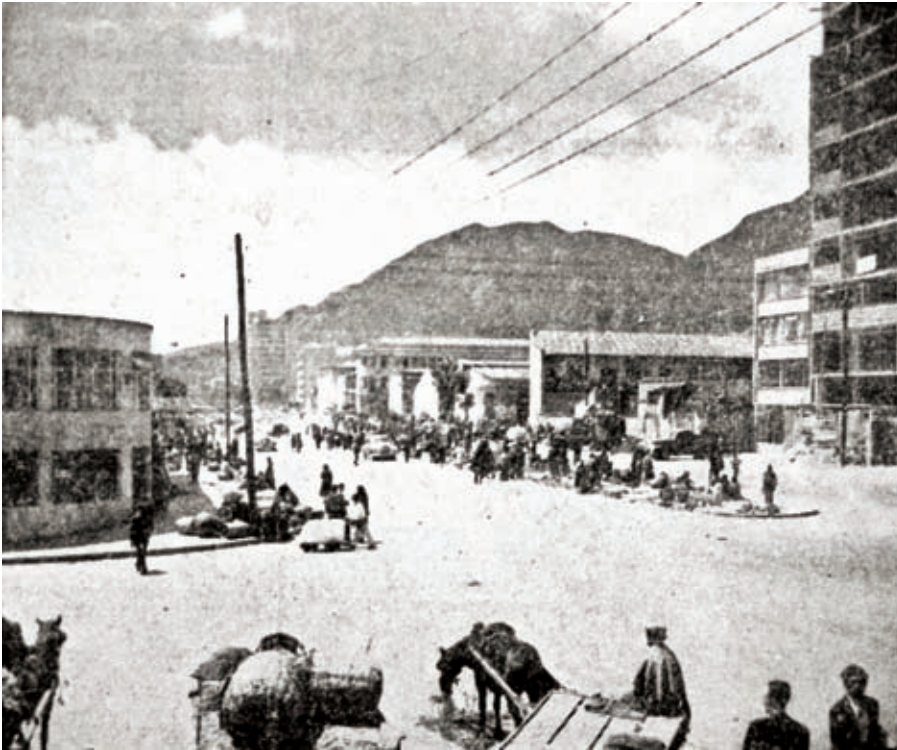
>1951. Panorámica de la avenida Carrera Décima en proceso de demoliciones y recebo. En primer lugar, a la derecha, el edificio Martín Gómez en construcción. Al fondo, la Plaza de mercado de Las Nieves. El Tiempo, 1951-7-25, p. 1
