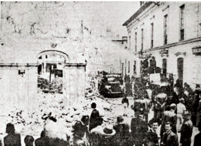
>Los bomberos colaboran con la demolición de la Morada del Altísimo arrojando chorros de agua para debilitar los muros. El Espectador , 1952-9-26, p. 7
