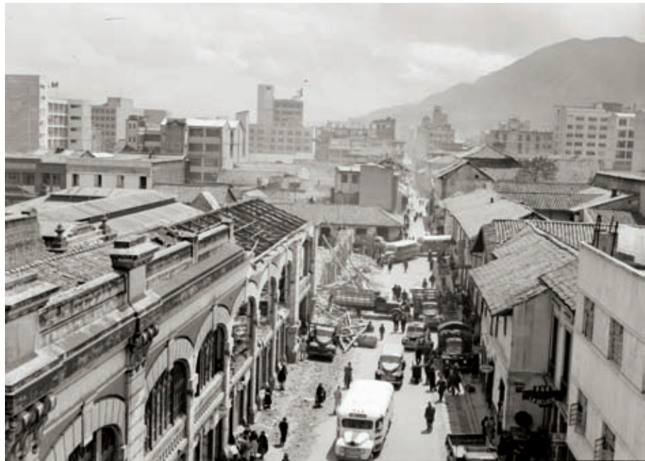
>Demolición plaza Central.
