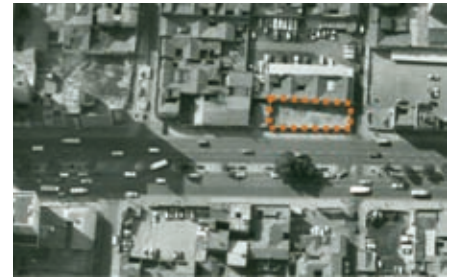
> 1967. Empieza a despejarse el lote de casas antiguas. Estado de la manzana tres años antes de la construcción del edificio Banco Antioqueño. La calle 19 aún no está ampliada en este sector. IGAC
