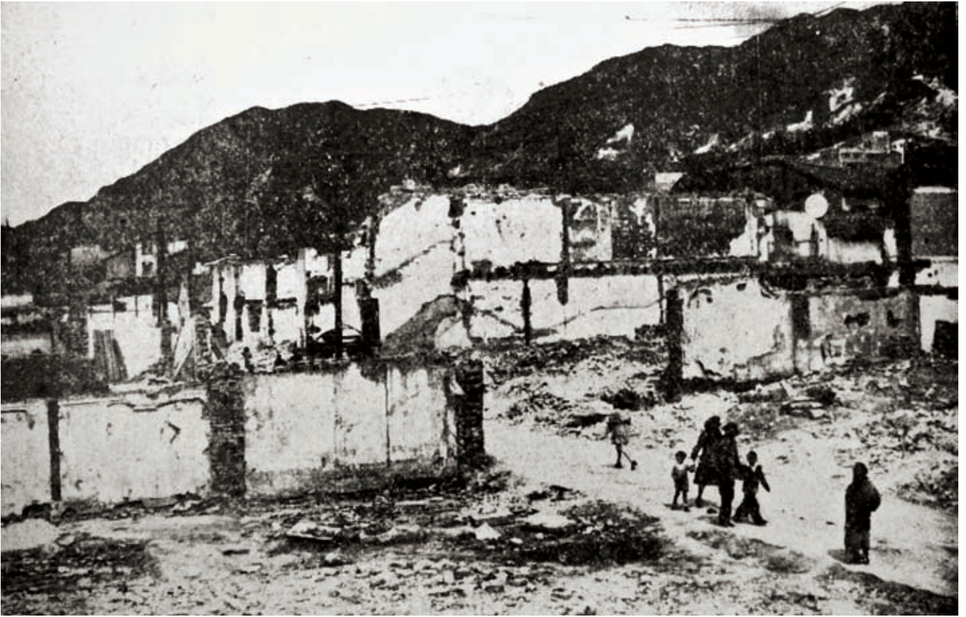
>Demoliciones en la carrera Décima. El Espectador , 1948-1-13, p. 12
