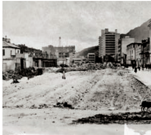
> Trabajos de ampliación de la carrera Décima. Foto: Daniel Rodríguez. IDPC. Colección Museo de Bogotá
