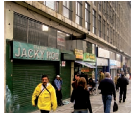
>Estado actual del zócalo de comercio sobre la carrera Décima, que sí ha perdido mucha calidad por las intervenciones en los locales. Foto: Carlos Niño Murcia
