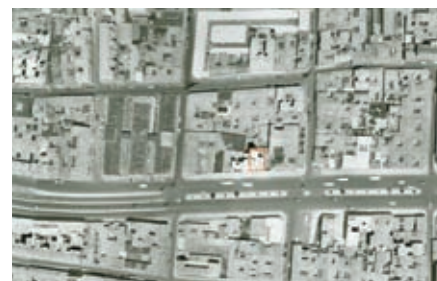
>1952. La carrera Décima ya construida generó la demolición de buena parte de los predios antiguos del costado oriental de la manzana. El edificio Martín Gómez se encuentra en construcción. IGAC
