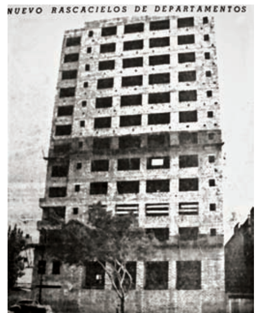
>Edificio Residencias el Parque en construcción. El Espectador , 1950-6-1, p. 11
