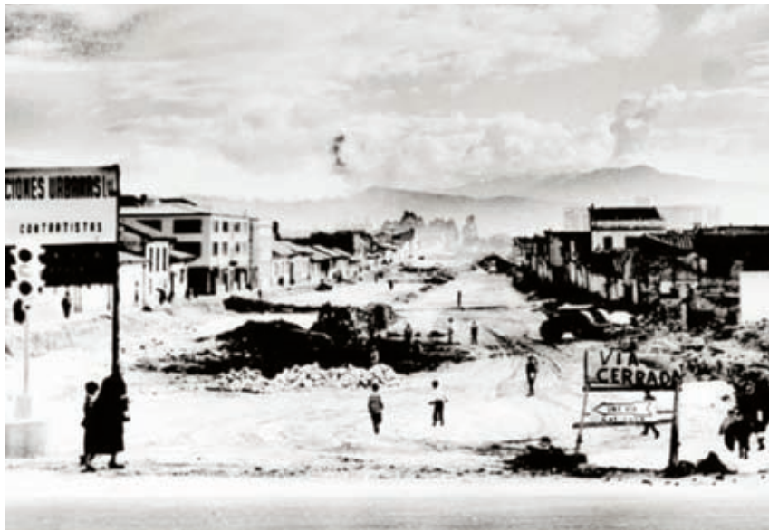
>Demoliciones carrera Décima entre calles 1 y 6.
