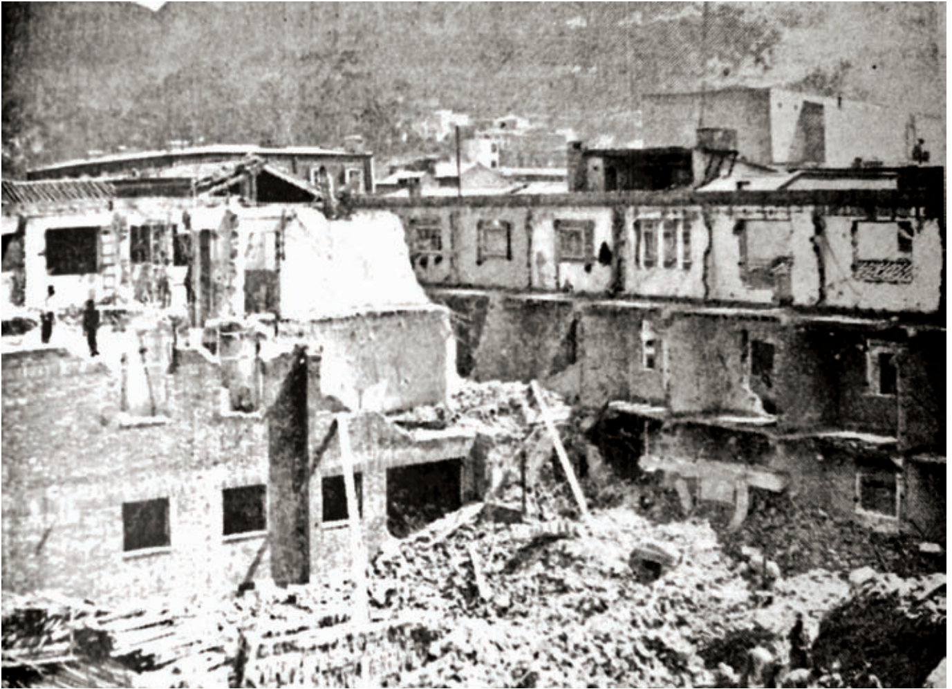
>Demoliciones parciales de Cité Restrepo, por la ampliación del perfil de la carrera Décima. El Espectador , 1950-12-14, p. 3
