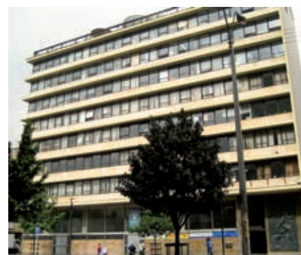
>Edificio Caja de Crédito Agrario y Minero. Después de su construcción ha sido conocido como Edificio Incora. Actualmente alberga la Unidad Administrativa Especial del Sistema de Parques Nacionales Naturales y el IDEAM. Foto: Carlos Niño Murcia
