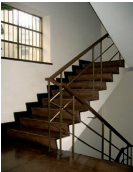
>Escalera del punto fijo y ventanas que iluminan desde el aislamiento posterior del edificio. Foto: Carlos Niño Murcia
