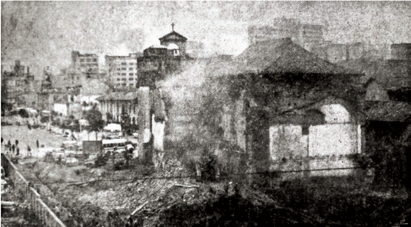
> Inicio de demolición de la iglesia de Santa Inés. El Tiempo , 1956-11-15, p. 3
