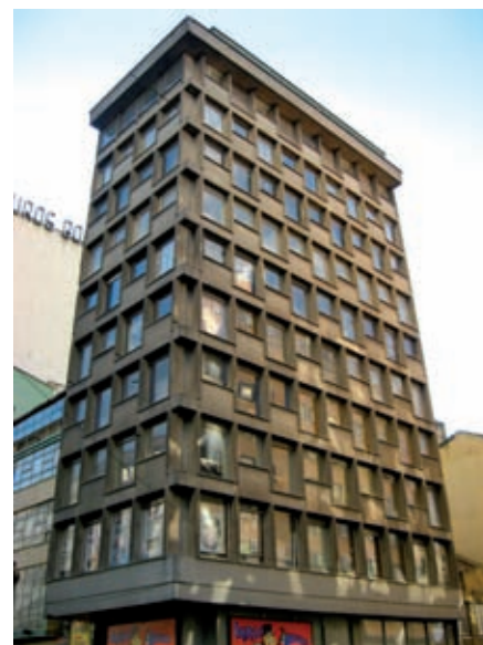
>Edificio Guevara. Fachada oriental sobre la carrera Décima y fachada norte sobre la calle 17. Foto: Carlos Hernández Llamas
