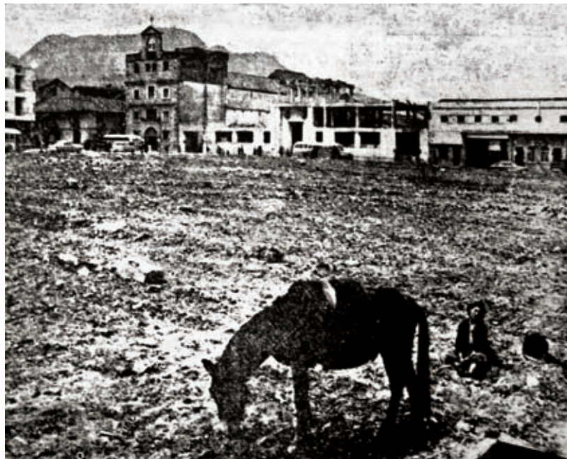
>Aspecto posterior a las demoliciones de la plaza Central de mercado. Al fondo la iglesia de Santa Inés. El Tiempo , 1954-4-15, p. 19
