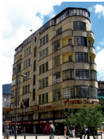
>Edificio Camacho Matiz, conocido también como Edificio Vicol, El Triángulo (1986), Centro Comercial Colonial (1996) y Nuevo Centro Comercial San Victorino (2008).
