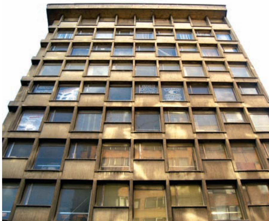
> Vista de la fachada sobre la carrera Décima. Foto: Carlos Hernández Llamas
