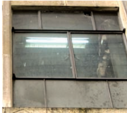
>Módulo de fachada desde el exterior. La ventanería en vidrio va de piso a techo y el que hace las veces de antepecho es esmerilado. Foto: Carlos Niño Murcia
