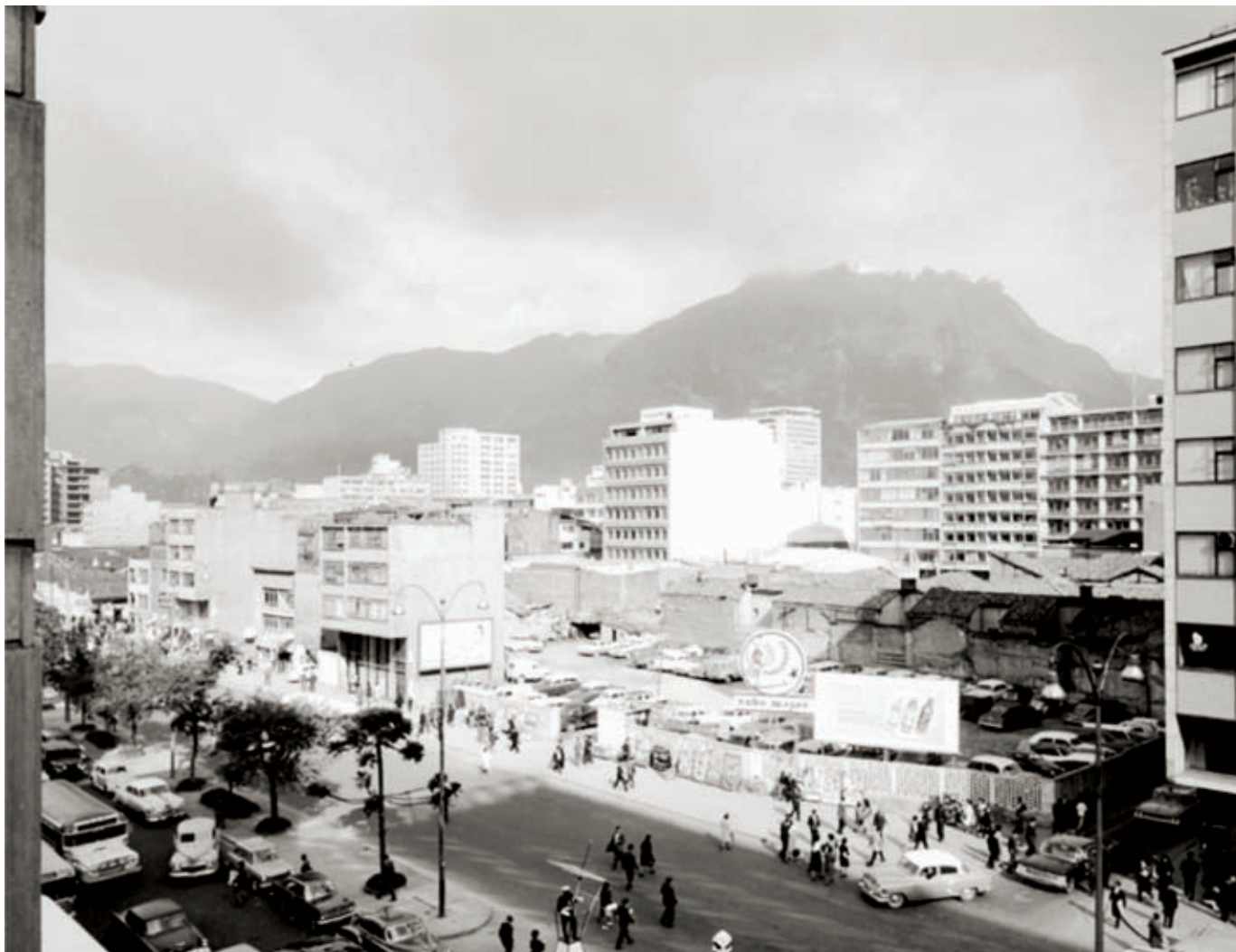
> Estado del lote en octubre de 1957, donde se construiría el edificio en 1974. Foto: Paul Beer. Instituto Distrital de Patrimonio Cultural – Colección Museo de Bogotá
