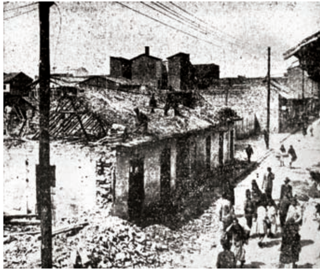
>Obras de demolición iniciadas por la ampliación de la carrera Décima. El Espectador , 1947-10-22, p. 5
