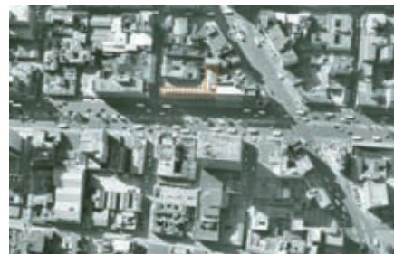
> 1967. Construcciones del perfil en altura de la avenida con los edificios vecinos a la Sociedad de Agricultores, el Banco de Bogotá (1959) en frente, y el edificio de Colombiana de Capitalización (1961) en la esquina de la calle 15. IGAC
