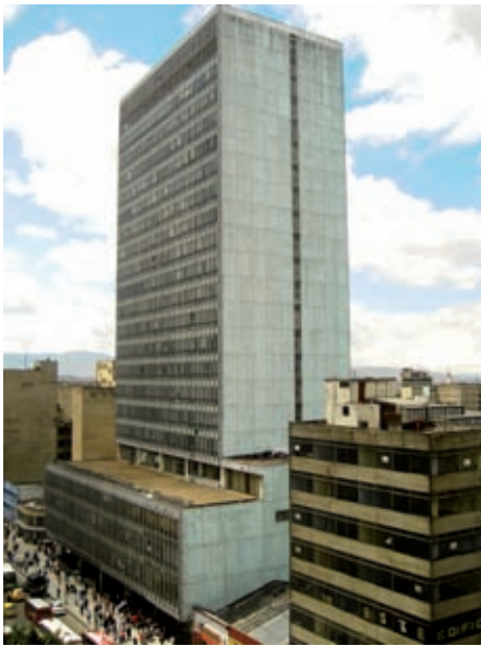
> Edificio Banco de Bogotá - Casa Principal, actualmente sede del Consejo de la Judicatura. También es conocido como Sede Judicial Hernando Morales Molina. Foto: Carlos Niño Murcia
