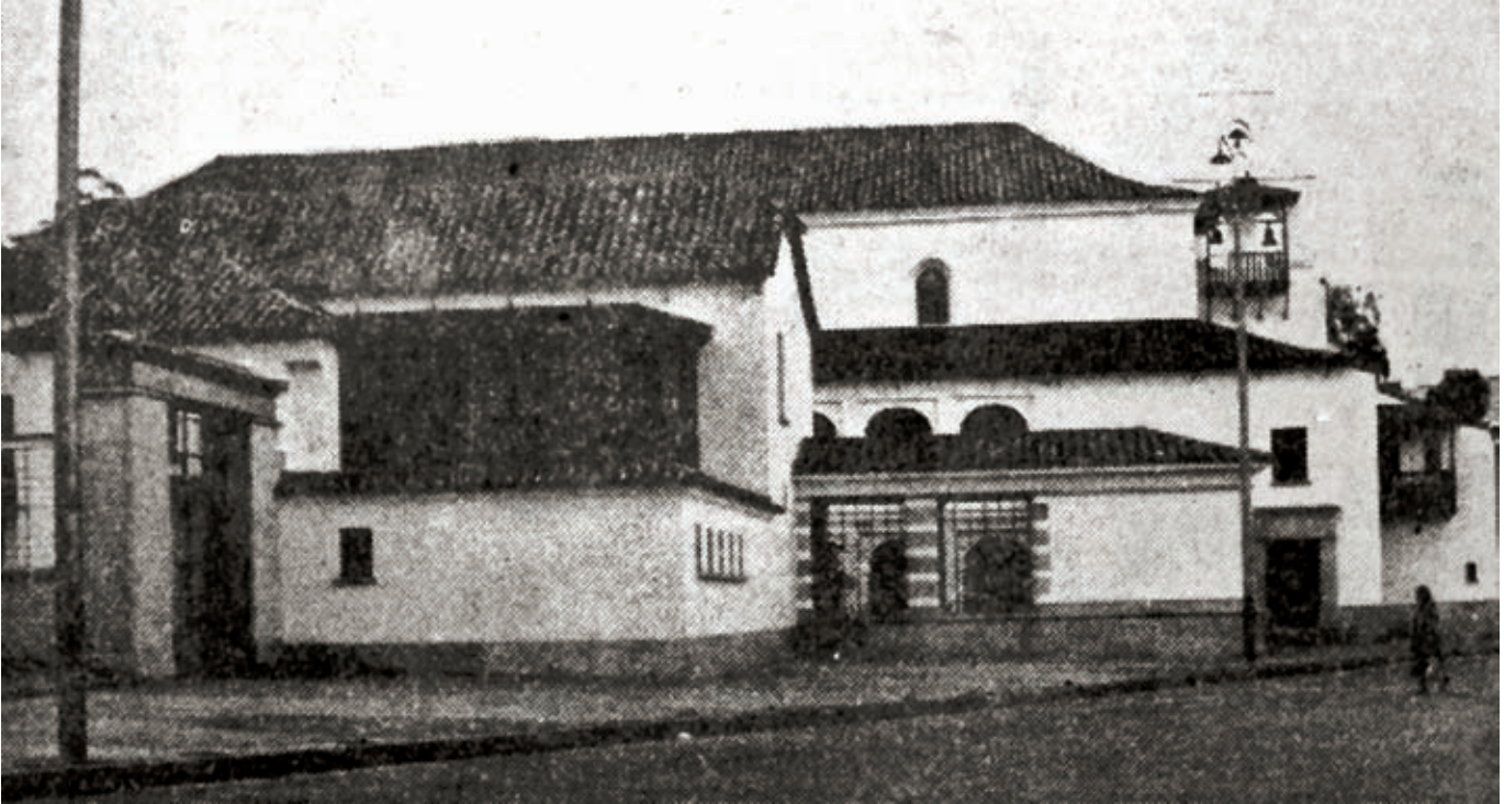
>Aspecto terminado de la reconstrucción de San Diego. El Tiempo , 1954-6-21, p. 3
