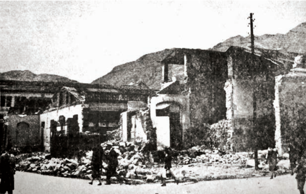
> Demoliciones de la plaza de mercado de las Nieves. El Espectador , 1950-6-1, p. 3
