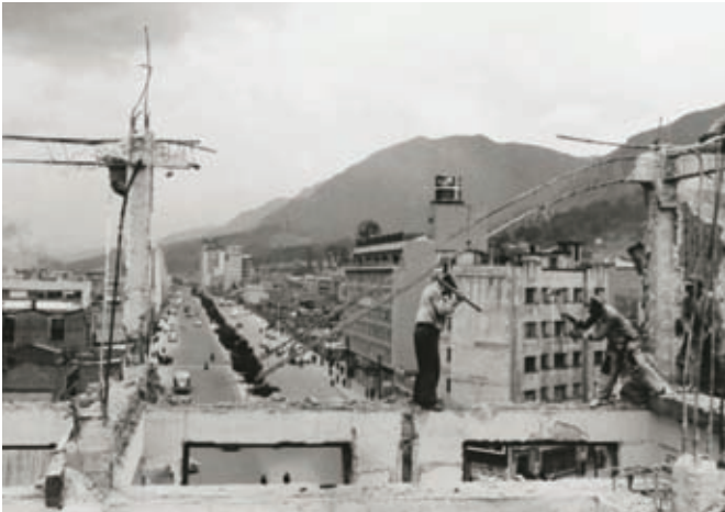
>Demolición Edificio Salgado. Carrera Décima vista al norte. Foto: Daniel Rodríguez. Instituto Distrital de Patrimonio Cultural Colección Museo de Bogotá
